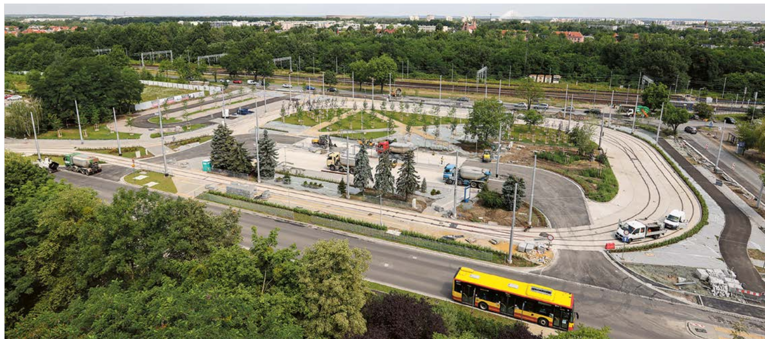
Trwają ostatnie prace porządkowe przy budowie pętli autobusowo-tramwajowej Wrocław Nowy Dwór (P+R), która ma charakter miniparku
